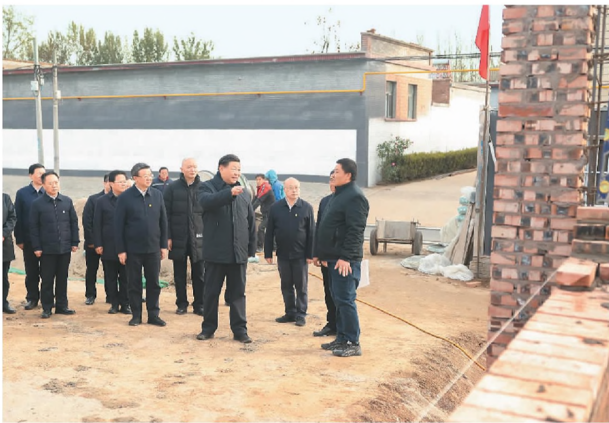
11月10日,中共中央总书记、国家主席、中央军委主席习近平在北京、河北考察灾后恢复重建工作。这是10日下午,习近平在河北保定涿州市刁窝镇万庄全村房屋重建施工现场考察。
