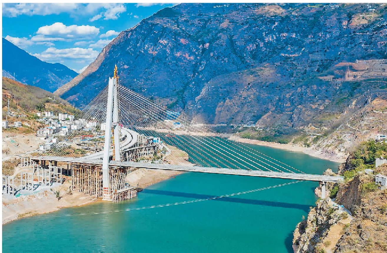
日前,贵州都匀市至云南香格里拉市高速公路(以下简称“都香高速”)云南昭通段全线建成通车,西南地区新增一条重要交通动脉。都香高速全长96公里,通车后将缩短四川泸县的通行时间从6小时缩短至约1小时。图为连接川滇两省的都香高速金沙江特大桥。
