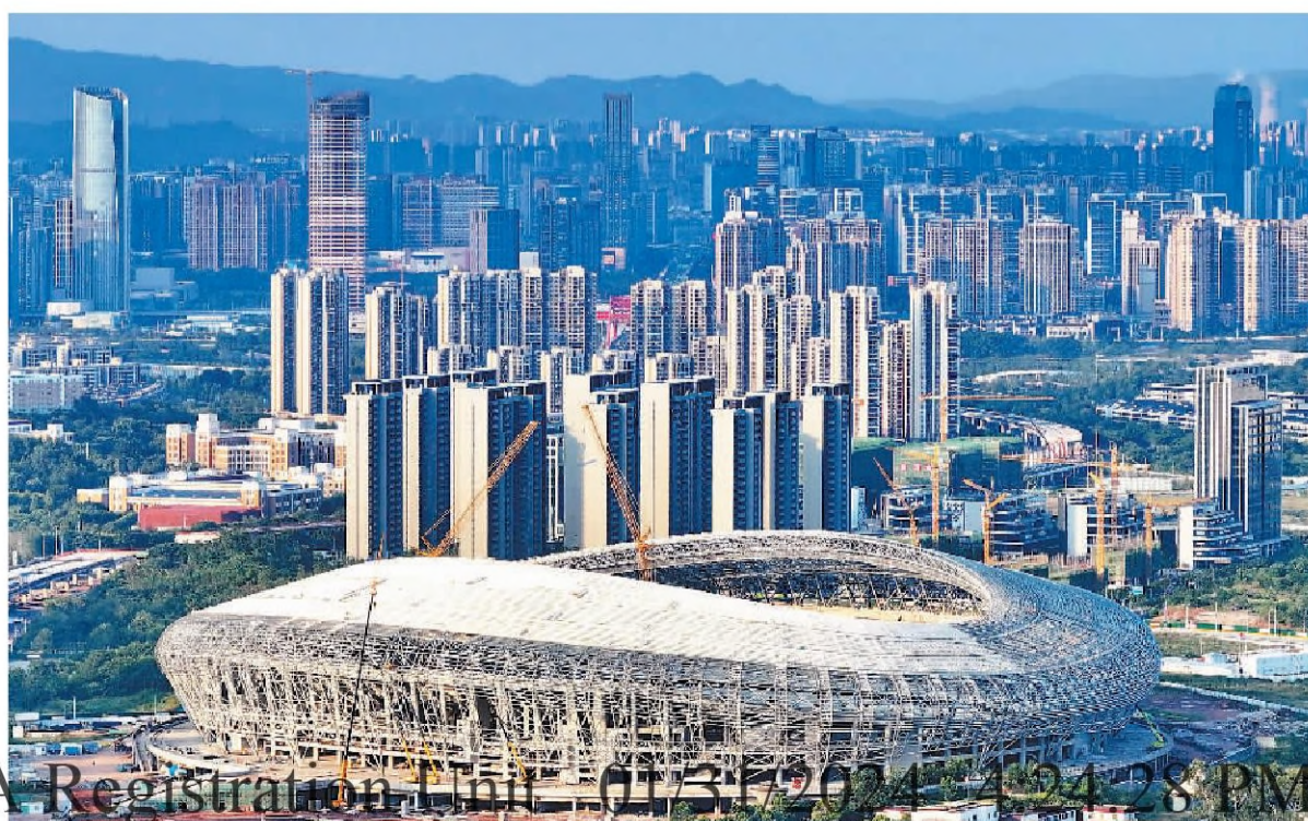
8月5日, 江西省赣州市全民健身中心综合体育馆建设工地, 工人在安装钢结构件和采光棚。场馆建成后, 不仅可以满足市民的健身需求, 还可以承办各级体育赛事等。朱海鹏摄(人民视觉)
