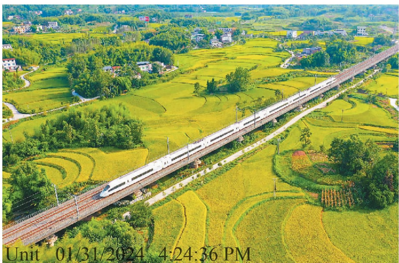
8月11日,重庆市梁平区双桂街道黄泥村,郑(州)万(州)高铁线周边,金色的稻田集中成片。高铁动车穿行稻田,与绿树、房屋形成一道独特的风景线。刘辉摄(人民视觉)
