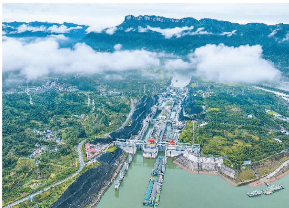
中国三峡集团发布消息,今年8月,三峡双线五级船闸共运行965闸次,通过船舶3737艘次,过闸货运量超1571万吨。投运20年来,三峡船闸首次月货运量超1500万吨。图为在湖北省宜昌市,船舶有序通过三峡双线五级船闸。 郑家裕摄(新华社发)
