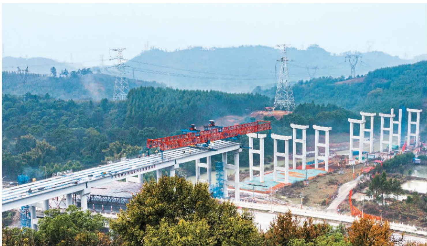
目前,广西壮族自治区贺州北过境线高速公路项目飞马特大桥正在施工建设。飞马特大桥全长1089米,是贺州北过境线高速公路项目控制性工程,计划于今年2月份实现半幅贯通。
