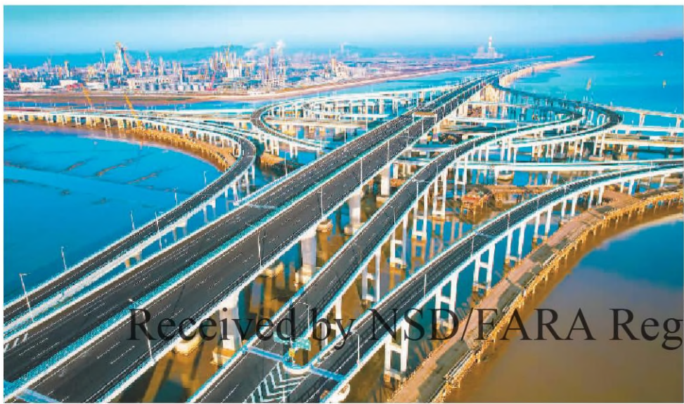
1月19日，杭州(杭州至宁波)高速复线宁波段一期工程正式通车，这也意味着亚洲最大海上交通枢纽——杭州湾复线宁波段一期项目滨海互通枢纽同步开通。该项目建成通车后，将与杭州湾跨海大桥、甬舟高速金塘大桥相接，缩短长三角南翼与上海、江苏等地的距离，极大便利杭州湾跨海居民出行。 吕奎元摄 (人民视觉)
