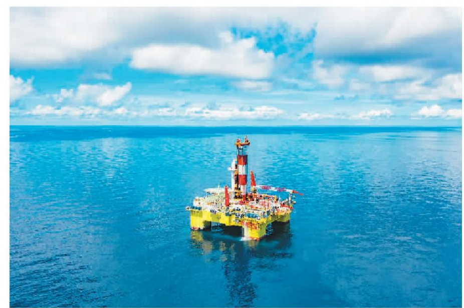
“深蓝探索”号钻井平台在开平南油田进行钻探作业。
