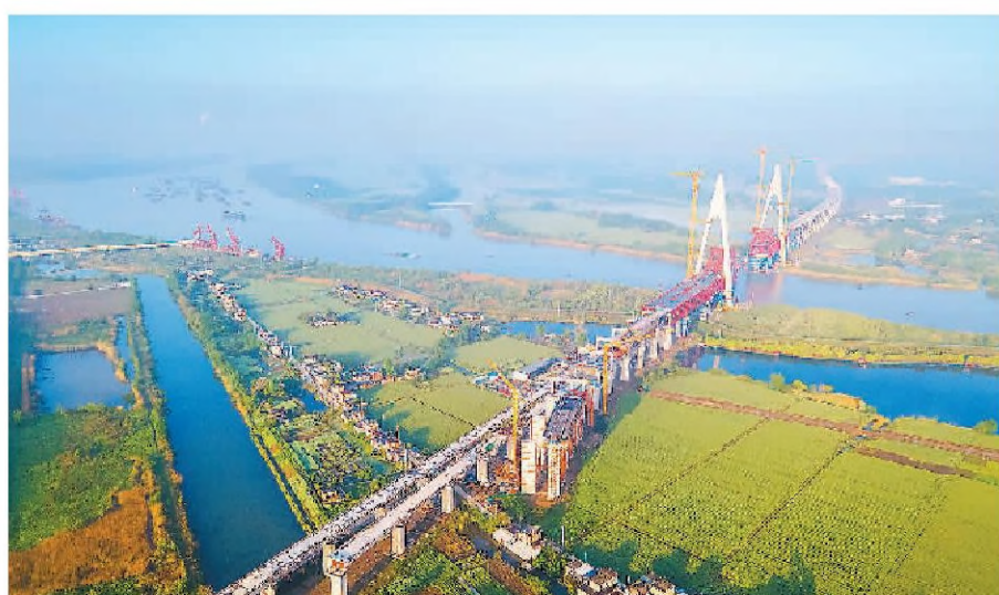
图为4月18日,巢马城际铁路马鞍山公铁两用长江大桥副汉航道桥主塔建设现场。 张明伟摄(人民视觉)
