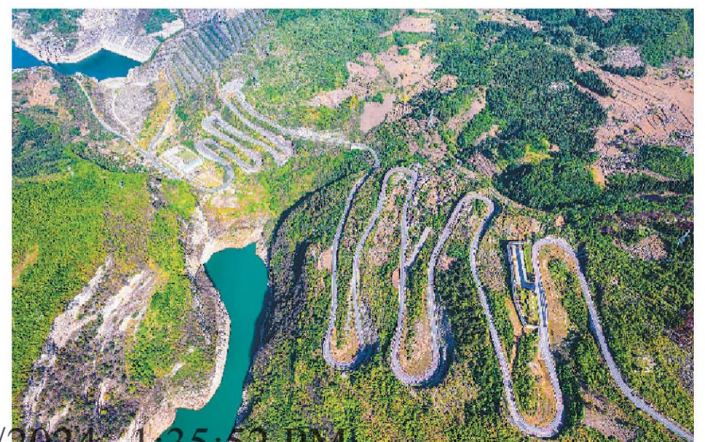
近年来,贵州省毕节市大力推进交通基础设施建设,不断优化城乡路网布局,构建起以高铁高速为骨架、国道省道为支撑、县乡公路为脉络的综合交通运输体系。图为该市织金县八步镇境内提质改造后的321国道。 史开心摄(人民视觉)
