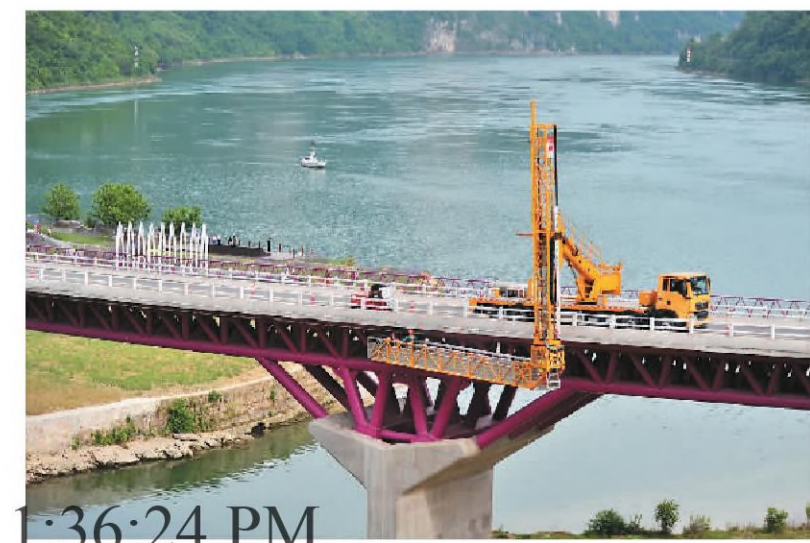
5月12日,专业技术人员对长江西陵峡畔的湖北省宜昌市夷陵区东溪镇莲沱畔大桥进行检查检测,形成“一桥一档”技术档案检查报告。张国荣摄(人民图片)
