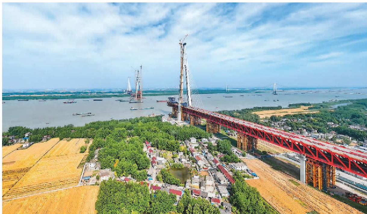
安徽省马鞍山市正在建设马钢大桥,主桥总长3248米,建成后将成为世界上首座双主跨超千米的三塔斜拉桥和世界最大跨度三塔斜拉桥,同时也是世界上最长钢桁梁斜拉桥。马钢大桥建设现场。张明伟摄(人民视觉)
