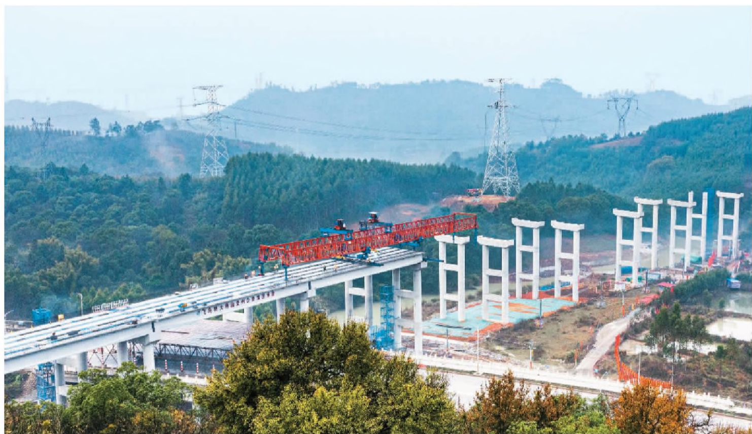
目前,广西壮族自治区贺州北过境线高速公路项目飞马特大桥正在施工建设。飞马特大桥全长1089米,是贺州北过境线高速公路项目控制性工程,计划于今年2月份实现半幅贯通。贺州北过境线项目建成后,将进一步完善广西高速公路网络,促进沿线经济发展。图为大桥施工现场。
