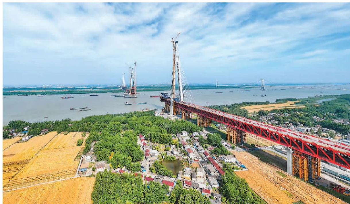
安徽省马鞍山市正在建设马钢大桥,主桥总长3248米,建成后将成为世界上首座双主跨超千米的三塔斜拉桥和世界最大跨度三塔斜拉桥,同时也是世界上最长钢桁梁斜拉桥。巢马城际铁路建设现场。 张明伟摄(人民视觉)
