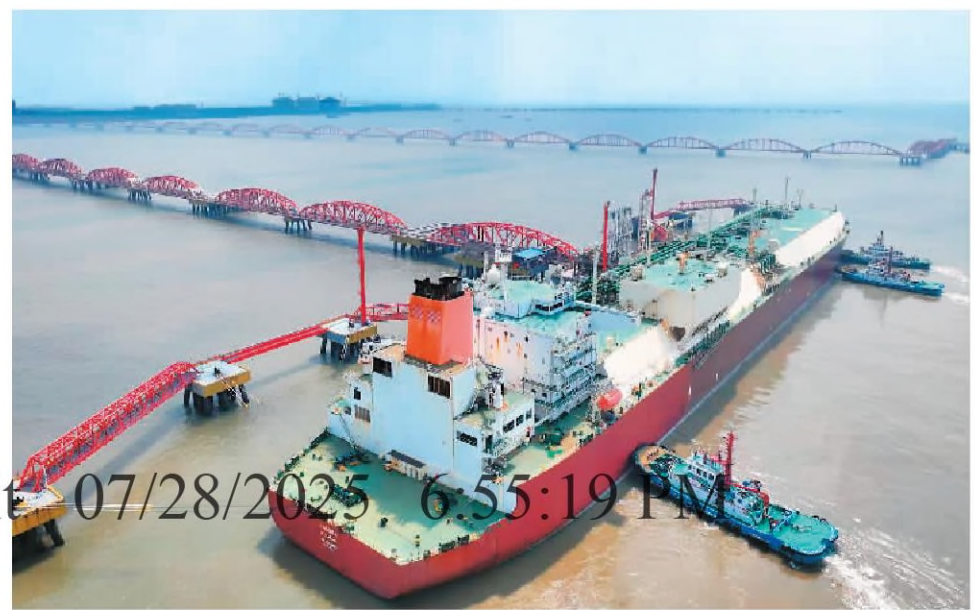
近日,来自卡塔尔的Q-Max型LNG(液化天然气)船舶“阿米拉”轮顺利靠泊江苏如东洋口港LNG码头,这是该船第29次运输进口LNG到中石化江苏LNG接收站。至此,江苏LNG接收站接卸LNG船达700艘次。图为靠泊在码头的“阿米拉”轮。 许丛军摄 (人民视觉)
