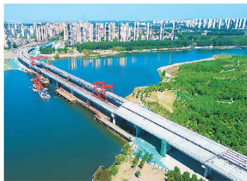
厂通路潮白河大桥项目主桥施工紧张进行中。
