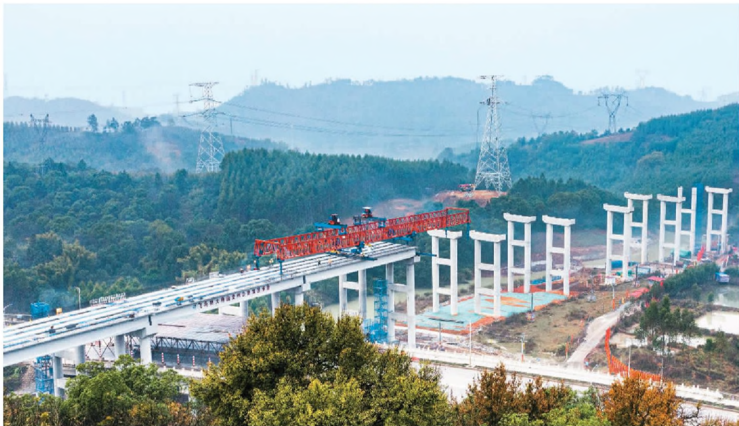
目前,广西壮族自治区贺州北过境线高速公路项目飞马特大桥正在施工建设。飞马特大桥全长1089米,是贺州北过境线高速公路项目控制性工程,计划于今年2月份实现半幅贯通。贺州北过境线项目建成后,将进一步完善广西高速公路网络,促进沿线经济发展。图为大桥施工现场。黎豪图摄(人民图片)
