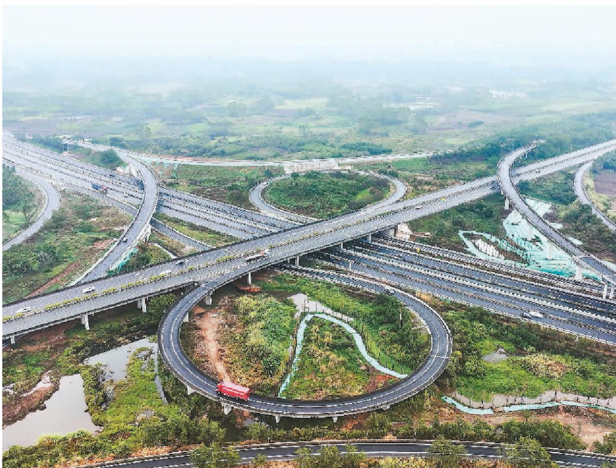
沈海国家高速茂港段改扩建工程临近收官,该项目位于需州半岛,起于广东省茂名市电白区,终于广东湛江江海区,全长约100公里,改扩建后将实现双向八车道,大幅提升路段通行能力,保障物流运输畅通。图为位于湛江市遂溪县的东坡岭枢纽,是沈海和兰海两条国家高速公路的交汇点。
