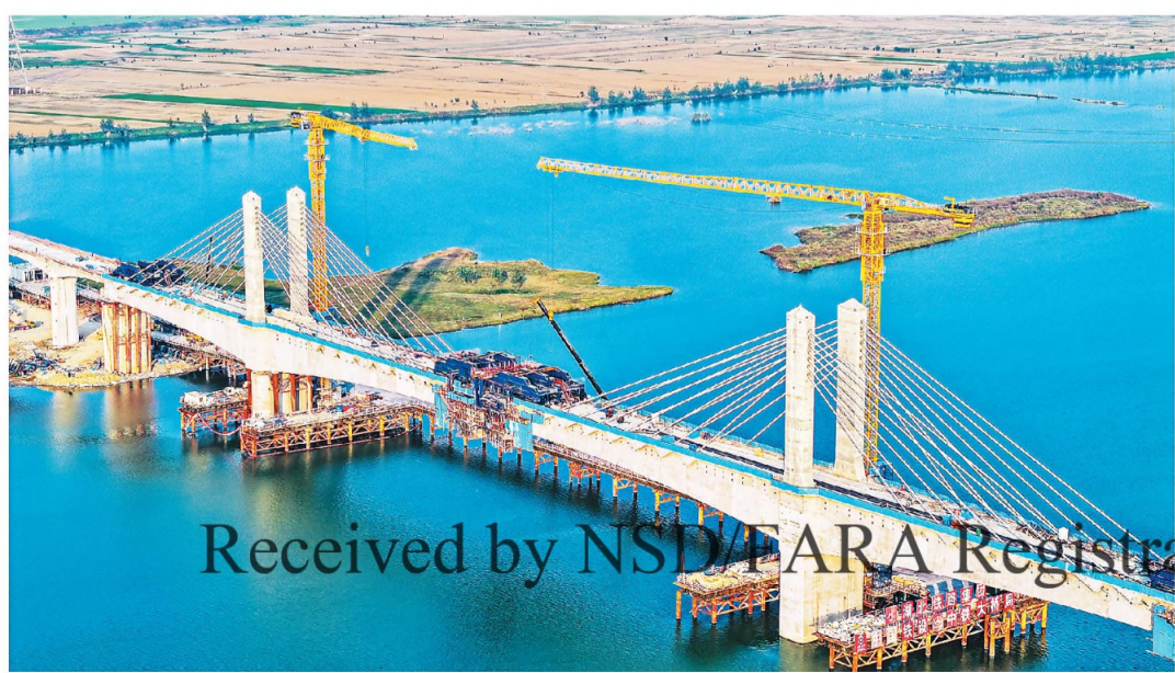
宣城江特大桥全长约二十五公里, 是连接皖南、皖北、皖东、皖西的重要通道。该桥主桥跨江, 是安徽省内首座采用“双塔双跨”设计的大桥。目前, 该桥已实现合龙, 预计年内可实现合龙。图为大桥建设中的景象。郑新涛摄(人民视觉)
