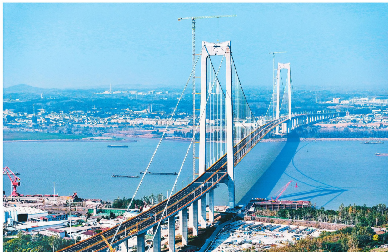
日前,龙潭长江大桥主体结构完工,预计今年年底基本建成。据悉,龙潭长江大桥连接江苏南京、扬州两市,设计时速100公里,是宁镇扬一体化的重要交通设施。图为建设中的龙潭长江大桥。 方东旭摄(人民视觉)
