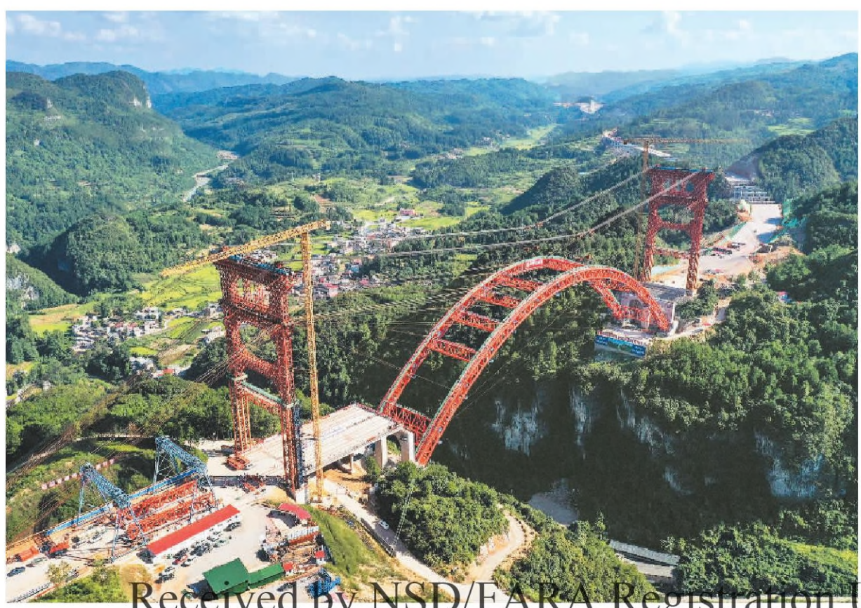
8月21日, 贵阳至平塘高速公路马场河特大桥主拱顺利合龙。该大桥位于贵州省贵定县盘江镇马场河村, 全长381.5米、主跨260米, 桥面设计为双向六车道, 是G7522贵阳至北海高速公路贵阳至平塘段控制性工程。图为马场河特大桥施工现场。新华社记者 杨文斌摄
