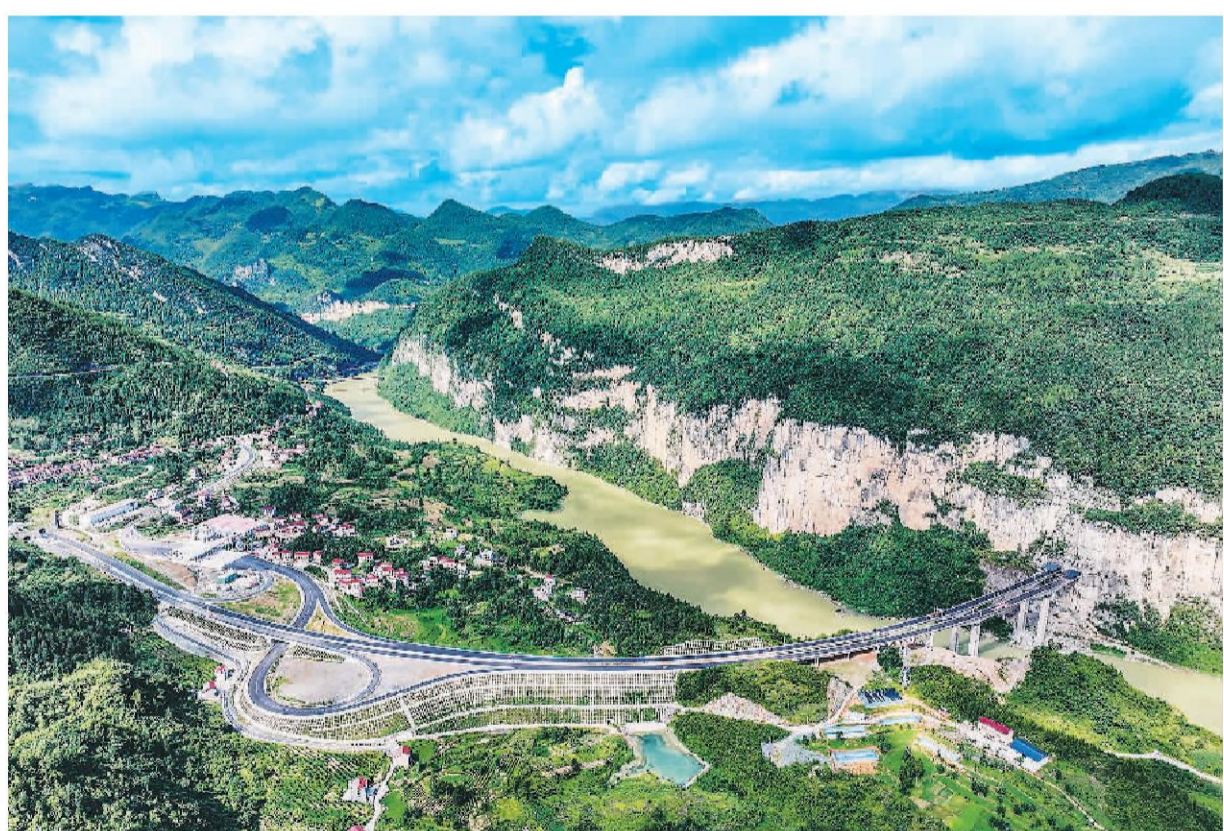
目前,渝湘复线高速彭水路标段进入收尾施工阶段。渝湘复线高速公路总里程280公里,由巴南至彭水、彭水至酉阳、武陵至道真三条路组成。全线建成后,将缓解既有渝湘高速拥堵状况。图为渝湘复线高速彭水路标段建设现场。
